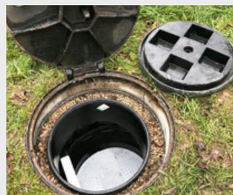
Tragfunktion durch handelsübliche Schachtabdeckung DN 800, Klasse D 400 in Kombination mit z. B. ROMOLD Stahlbetonaufleger BARD 84 VSD (gesondert zu beziehen)
