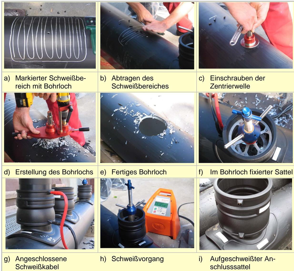
Abb. 2: Einbau des PLASSON LightFit Anschlussstells
