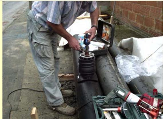
f) Befestigung des Sattels im Bohrloch
