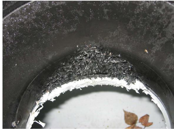
Abb. 9: Veränderungen nach Einsatz der Kettenschleuder
