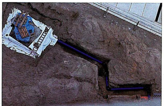
**Bild 4:** Vogelperspektive vom Dach der Elbphilharmonie: Grundwasserleitung vom Tiefenbrunnen in da 225 mm mit PLASSON Fusamatic Elektroschweiß fittings
