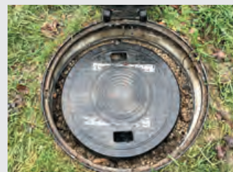
Dichtfunktion durch PP-Abdeckung DN 625 verhindert das Eindringen von Wasser, auch in Überflutungsbereiche.
