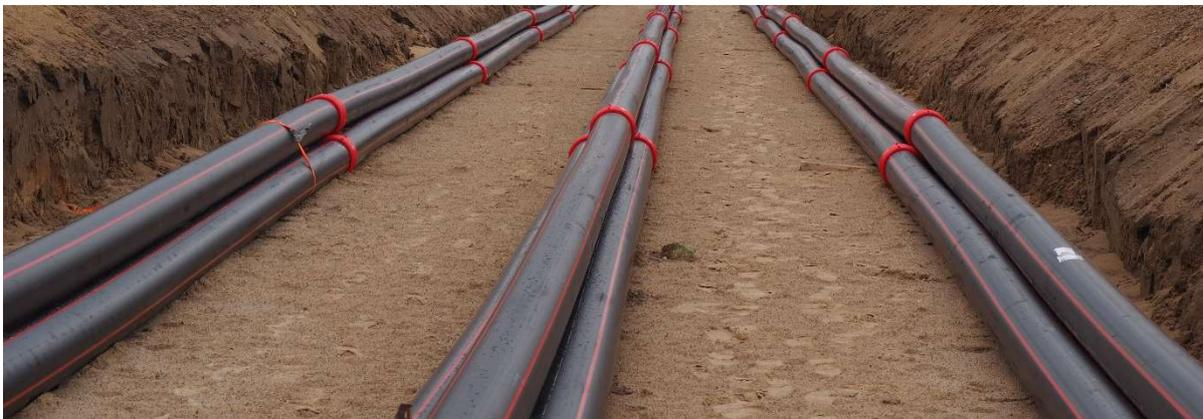
Bild 1: Perfekte Verbindung – Gerodur EMDS LHT®-Kabelschutzrohre und PLASSON PE-RT Elektroschweißmuffen
