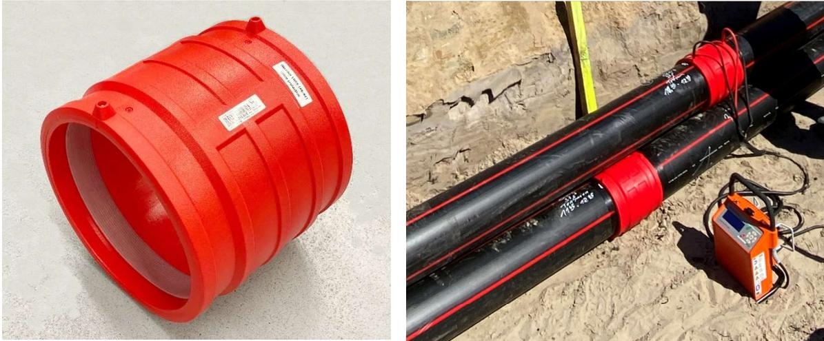
Bild 5: Rote PLASSON PE-RT Elektroschweißmuffe und Verschweißung der Muffe mit Schutzrohr auf der Baustelle
