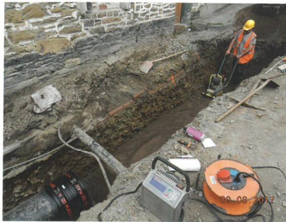
**Bild 2:** Verlegung des Mischwasserkanals
