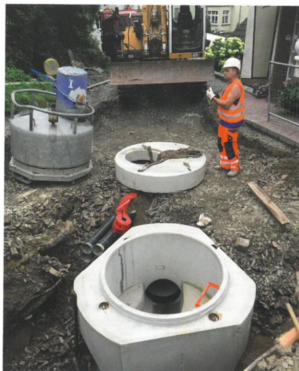
**Bild 3:** Betonfertigteilschacht mit integriertem PLASSON LightFit-Betonschachtadapter
