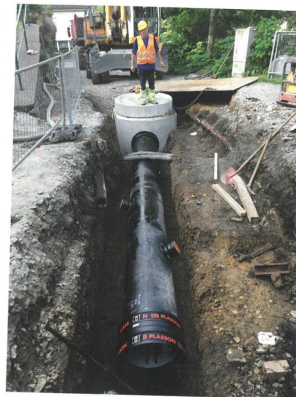
**Bild 4:** Neu verlegter PE-Hauptkanal d 450 mit PLASSON Schachtanschluss und Anschlusssätteln
