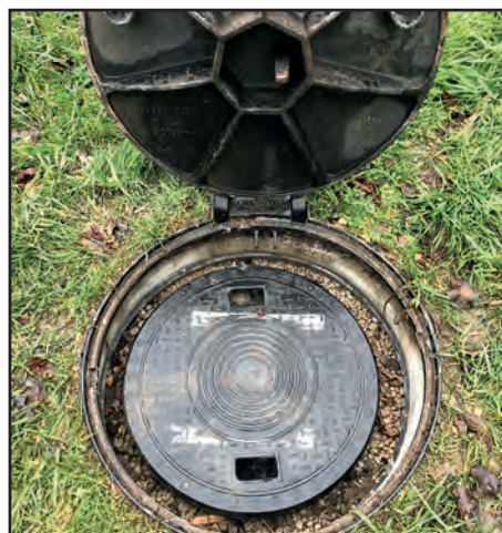
Dichtfunktion durch PE-Deckel DN 625 verhindert das Eindringen von Wasser, auch in Überflutungsbereichen
