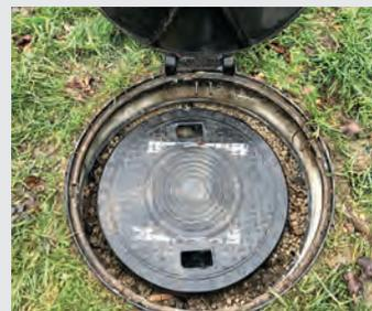
Dichtfunktion durch PE-Deckel DN 625 verhindert das Eindringen von Wasser, auch in Überflutungsbereichen
